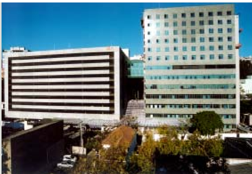
Com mais de 16 mil internações por ano, o HMV conta com equipamentos da CP instalados em locais de atendimento de urgência e emergência no hospital
