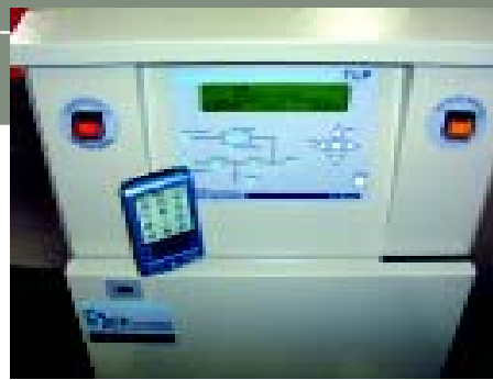
No-Breaks podem ser calibrados via Palm Top sem a necessidade de um cabo serial, apenas com o recurso da comunicação sem fio
