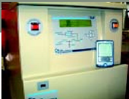
No-Breaks podem ser calibrados via Palm Top sem a necessidade de um cabo serial, apenas com o recurso da comunicação sem fio
